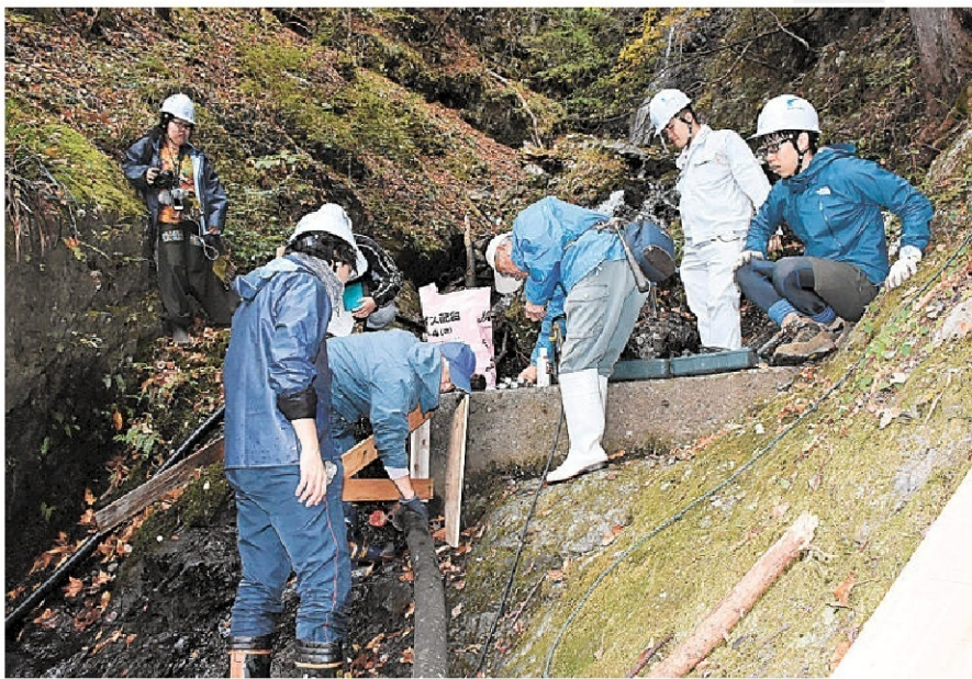
近隣住民と一緒に取水口の改良工事に取り組む静大生ら＝静岡市葵区
