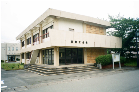
旧高柳記念館改修前外観
