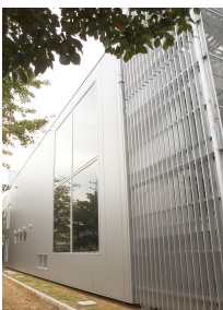
太陽熱集熱パネル (ソーラーウォール)
