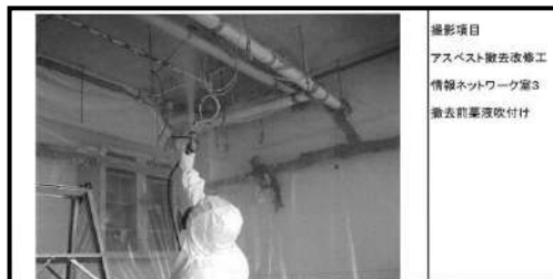
2. 粉じん飛散抑制剤の吹き付け
