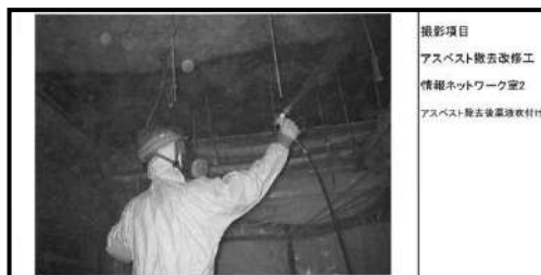
5. 粉じん飛散抑制剤の散布
