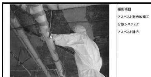
3. アスベスト含有吹付け材の除去
