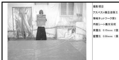
1. 床・壁の養生
