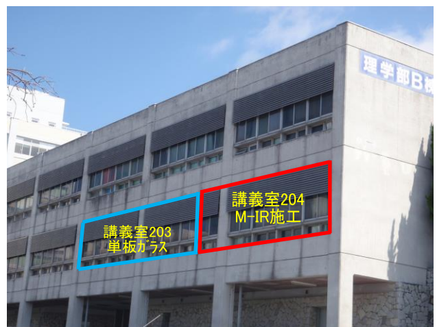
・理学部B棟西面外観
