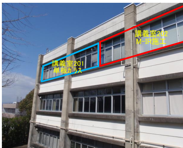
・教育学部G棟南面外観
