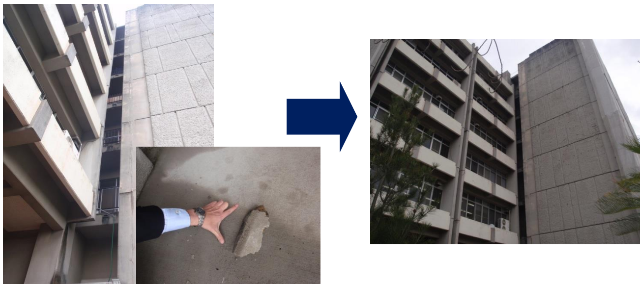
農学部A棟外壁剥落補修状況
