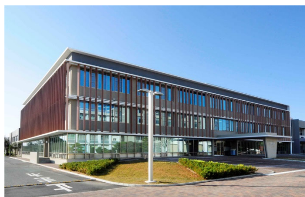
附属図書館分館・学生支援棟
