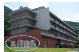
川根温泉メタン発電施設
