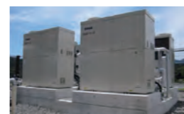
ガスエンジン発電機
