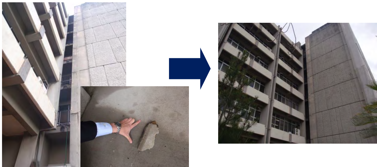
農学部A棟外壁剥落補修状況
