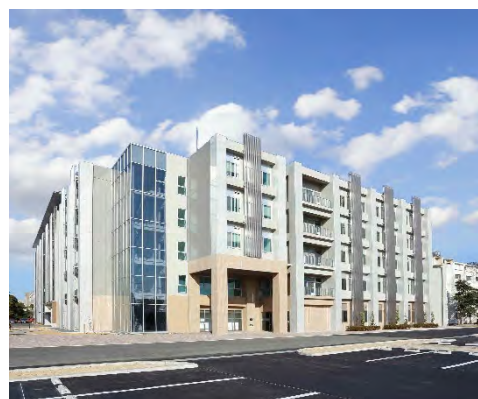
電子工学研究所新棟
