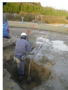
給水管の腐食による漏水復旧状況
