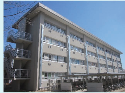
23年度 あかつき寮改修〔施設整備費補助金・目的積立金〕
