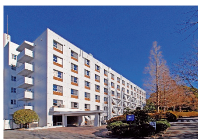
人文社会科学部A棟改修工事
