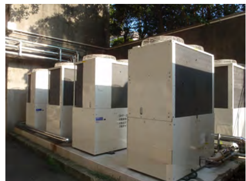
ガス式ヒートポンプ型空調室外機
