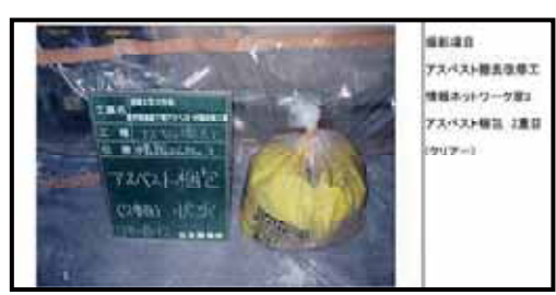
4. 除去したアスベストの袋詰め
