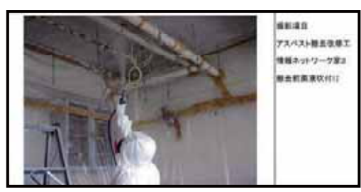
2. 粉じん飛散抑制材の吹き付け
