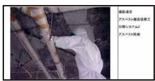
3. アスベスト含有吹付け材の除去
