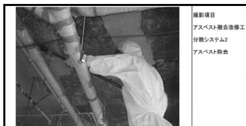
3. アスベスト含有吹付け材の除去
