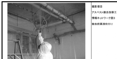
2. 粉じん飛散抑制材の吹き付け
