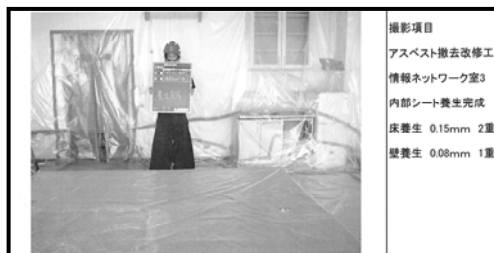
1. 床・壁の養生
