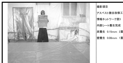
1. 床・壁の養生
