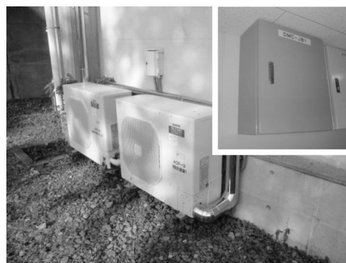
高効率空調室外機とデマンドコントローラー装置
