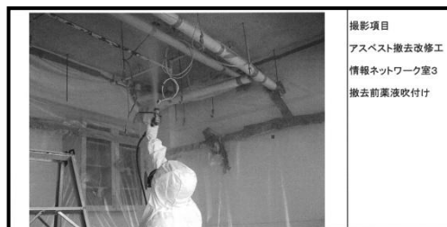
2. 粉じん飛散抑制材の吹き付け
