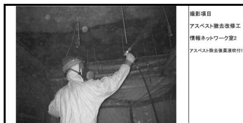
5. 粉じん飛散抑制材の散布
