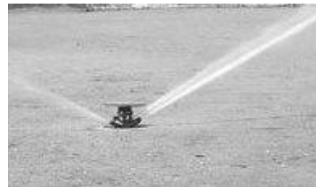
附属島田中学校 プール水再利用散水設備
