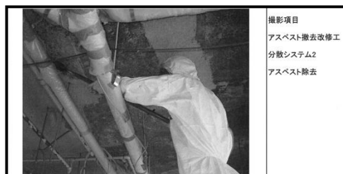
3. アスベスト含有吹付け材の除去
