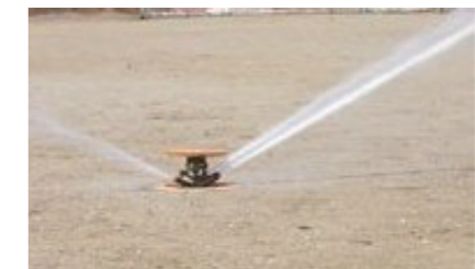
附属島田中学校 プール水再利用散水
