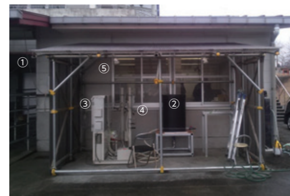
①パーラー、②処理水槽、③ポンプ等制御盤、④流量計、⑤計測室 図3: 現場実験(富士宮市静岡県畜産技術研究所)
