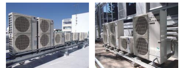
(大谷)理学部B棟改修機械設備工事
