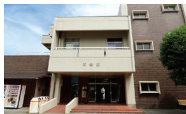
南会館 South Hall
