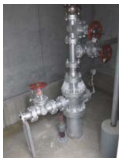
川根温泉の掘削井
